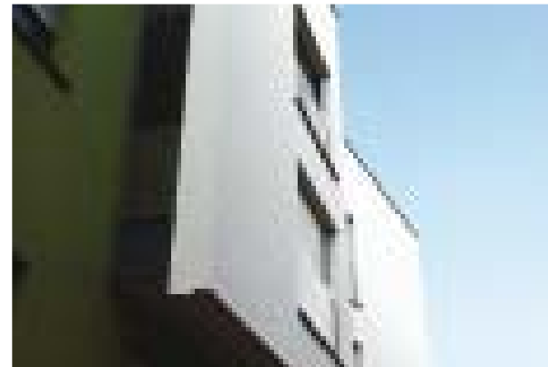
Esch, rue du Puits: Fassade eines Appartementshauses. Metaform
